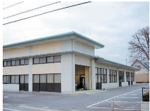
検査施設外観
